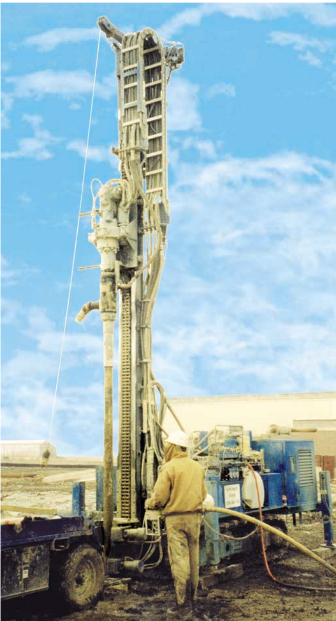
Geothermal drilling with discharge head Geothermische Bohrungen mit Auswurfkopf (Preventer)
