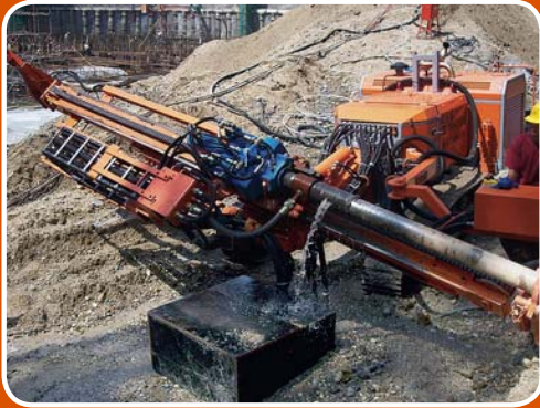
Hong Kong - Water Drainage Hole Drilling \phi 114.0\text{mm} Hong Kong - Entwässerungsbohrung \phi 114.0\text{mm}
